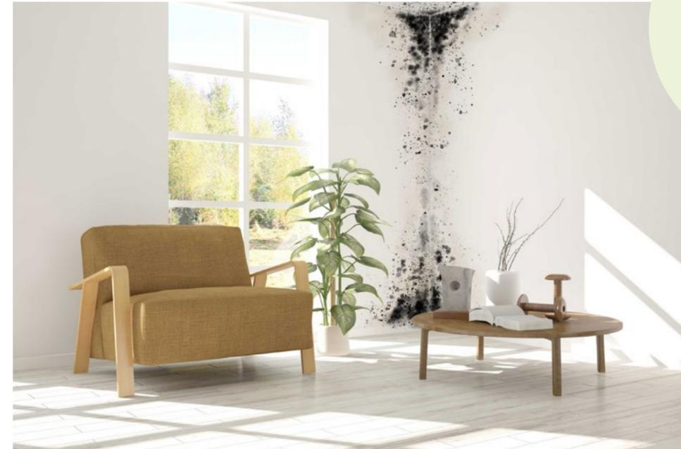
Die Lofec Flächenheizung ist ein echter Allrounder in der Sanierung. Egal ob es sich um eine Kernsanierung im Deckmal-schutz, oder um eine Schimmel-sanierung handelt – Lofec hat für alle Anforderungen eine Lösung parat. Hierbei wird die Wandtemperatur dauerhaft oberhalb des Taupunktes gehalten.
