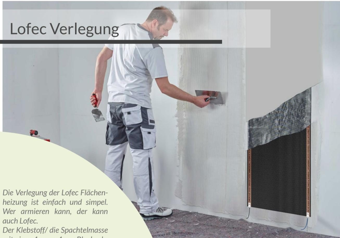
Die Verlegung der Lofec Flächenheizung ist einfach und simpel. Wer armieren kann, der kann auch Lofec.
